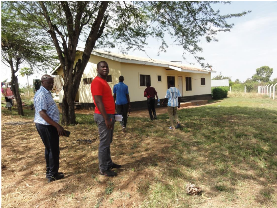
Een van de opgeleverde lerarenhuisjes van de Vocational Open School in Shirati
